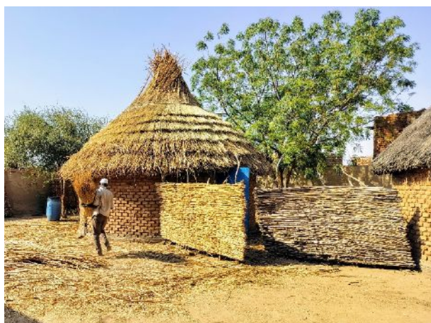
Figure 7: Remplacement de la toiture d'une hutte
