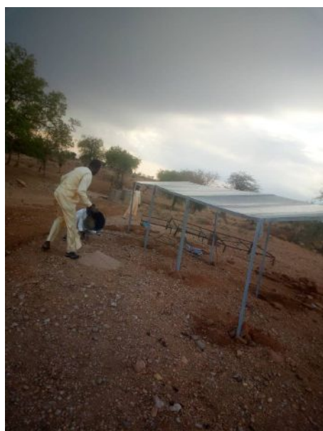
Figure 3 : Le personnel de SAS achève la construction de la structure des panneaux solaires à Toundjoung
