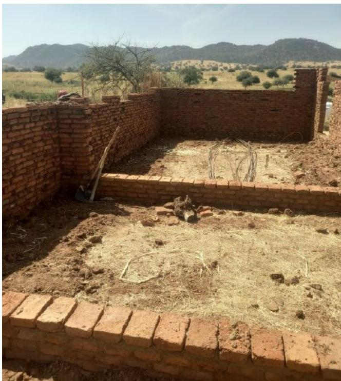
Figure 8 À Limane : construction des murs de l'école
