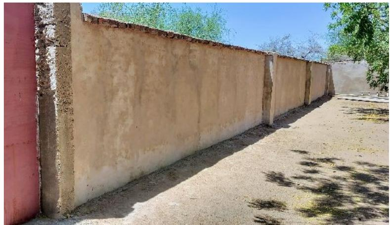
Figure 9 À Hadjer Hadid : les murs à l'intérieur et du côté nord ont été renforcés avec du ciment
