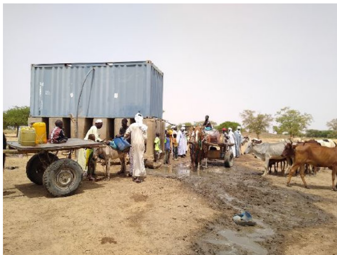
Figure 5 - Château d'eau en conteneur maritime à Djoroko
