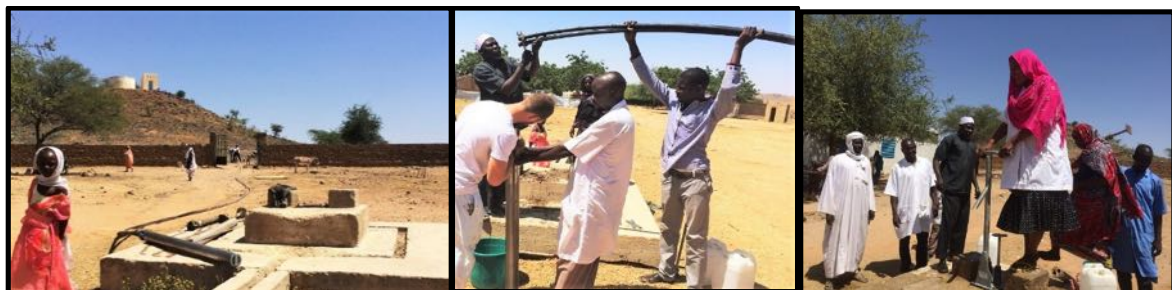
Figure 3 - Réparation de pompe au centre de santé Hadjer Hadid
