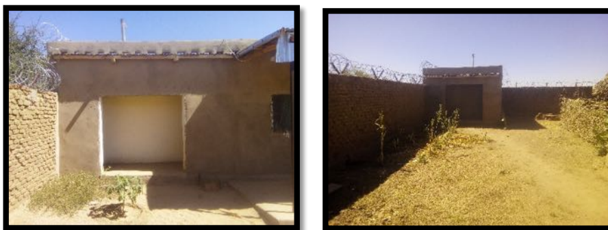
Figure F : Toilettes (une devant de la base et l'autre derrière)
